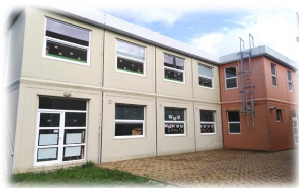
Foto 2 – Kontejnerová přístavba MŠ
